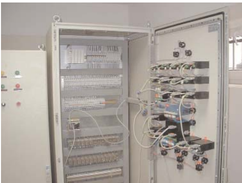
Sistem de excitație pentru motoare sincrone de 5100 KW
