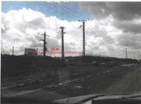
Vedere cu amplasamentul punctului de prelevare și distanțe de poziționare.
