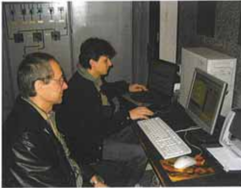
Masuratori de performanta la Centrala Hidroelectrică Vâlcea
