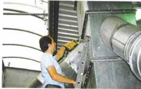
Fig. 1. Determinare COV (aparat portabil, detector de fotoionizare) în canalizare de evacuare
